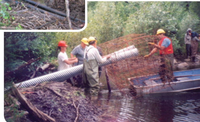
Installation d'un cube Morency Joanne Marchesseault
